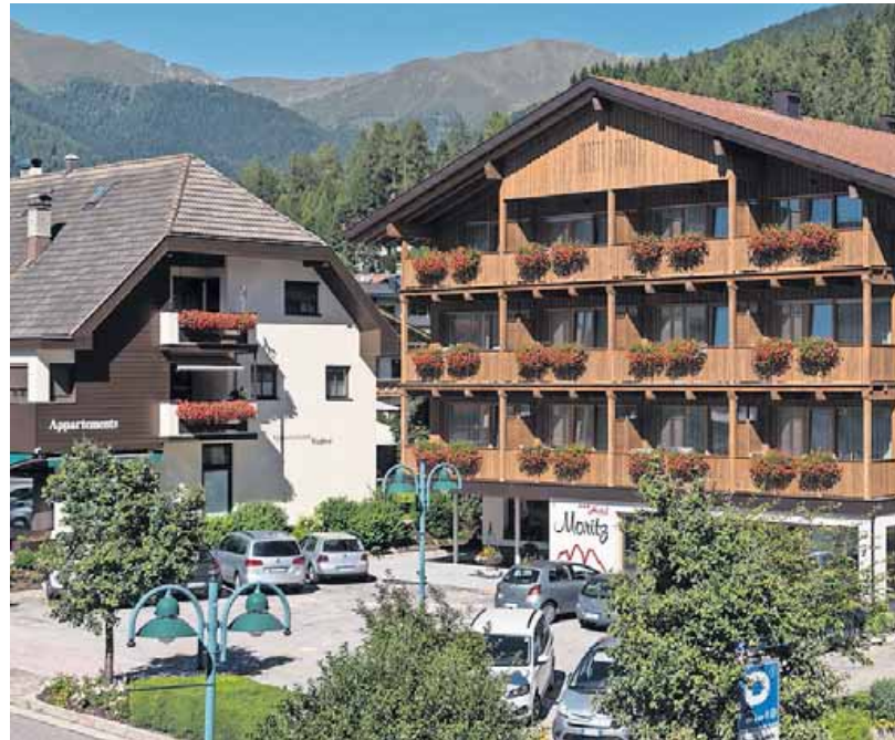
Die neue Holzfassade strahlt Ruhe und Wärme aus.
