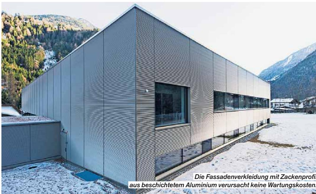
Die Fassadenverkleidung mit Zackenprofil aus beschichtetem Aluminium verursacht keine Wartungskosten.
